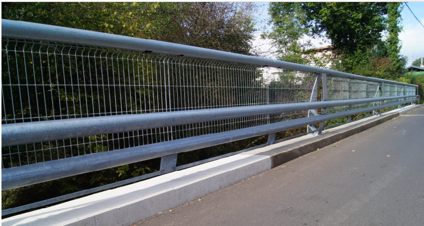
Le système fusible permet la réutilisation des ancrages après un impact
