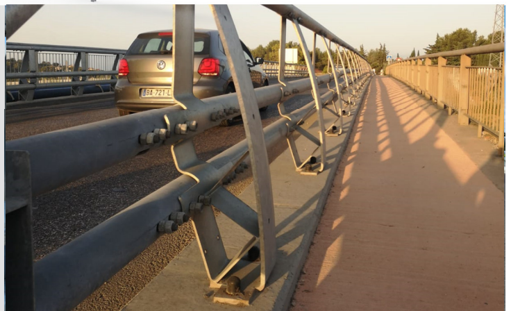
Installation avec ancrages mécaniques validée. Ancrages chimiques possibles
